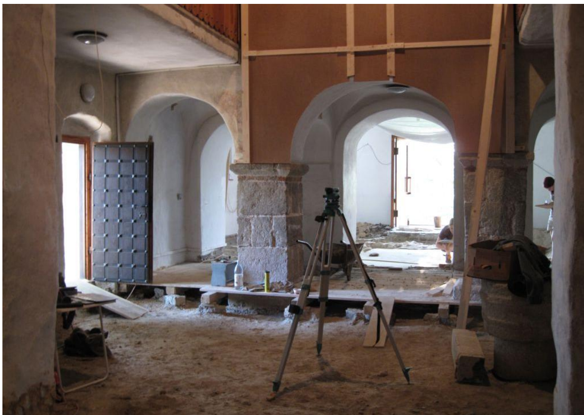
Interiér kostela sv. Juraja po zahájení rekonstrukce v červenci 2010
