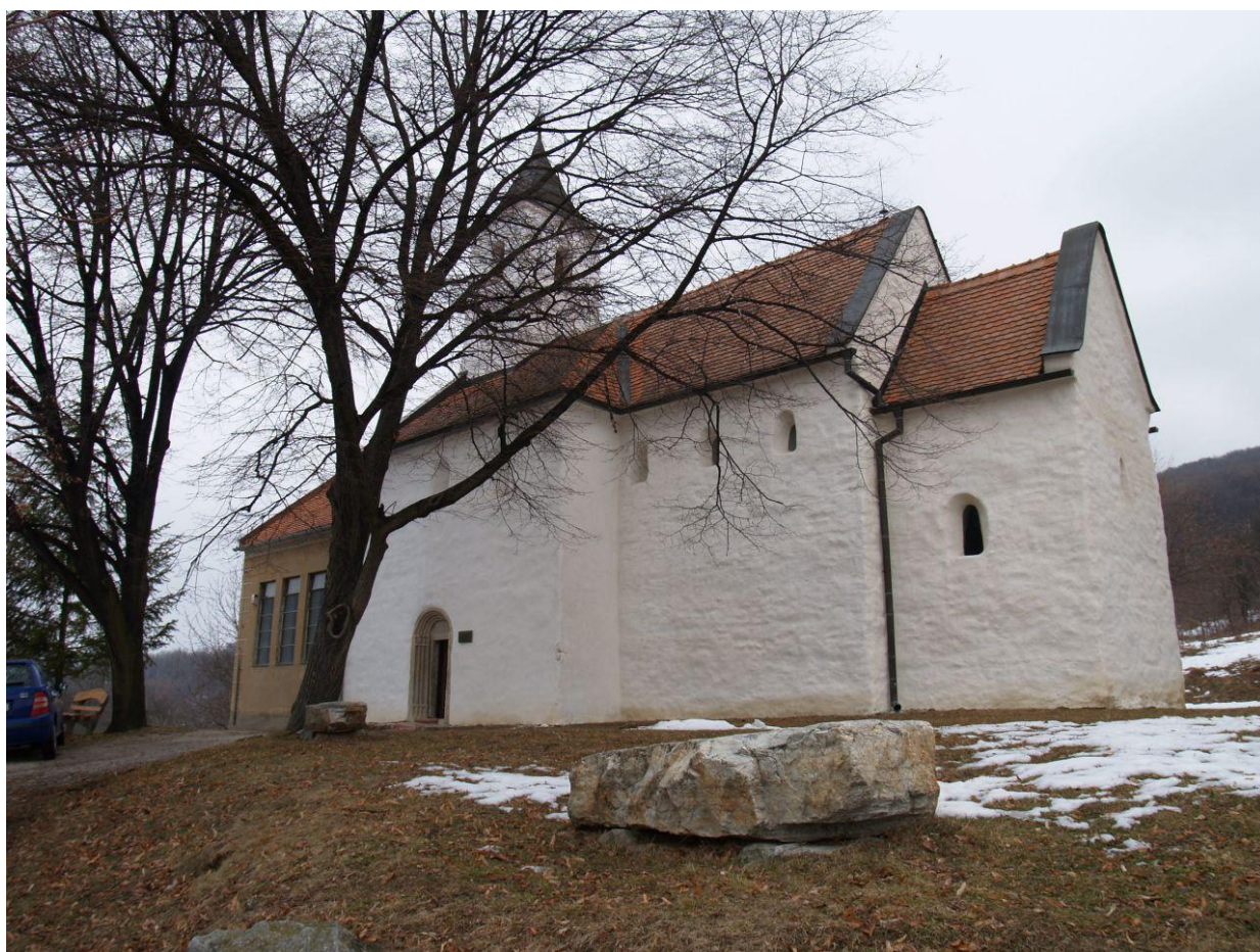
Exteriér kostela sv. Juraja, stav před zahájením rekonstrukce
